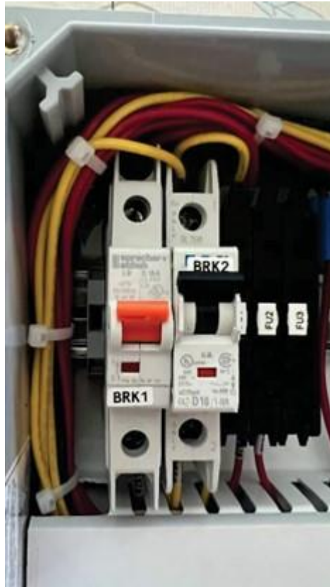
Figura 6-3: Posiciones de los disyuntores del panel de control para realizar mantenimiento en la GREEN MACHINE
