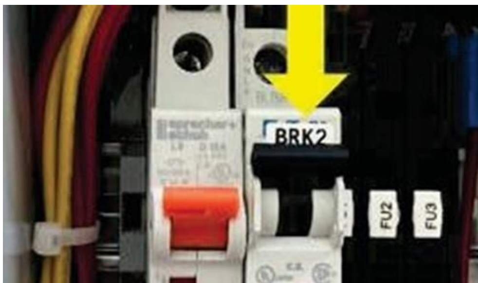
Figura 3-9: Disyuntor de apagado de derivación del dispensador (BRK2) en la posición ARRIBA (CERRADO)
