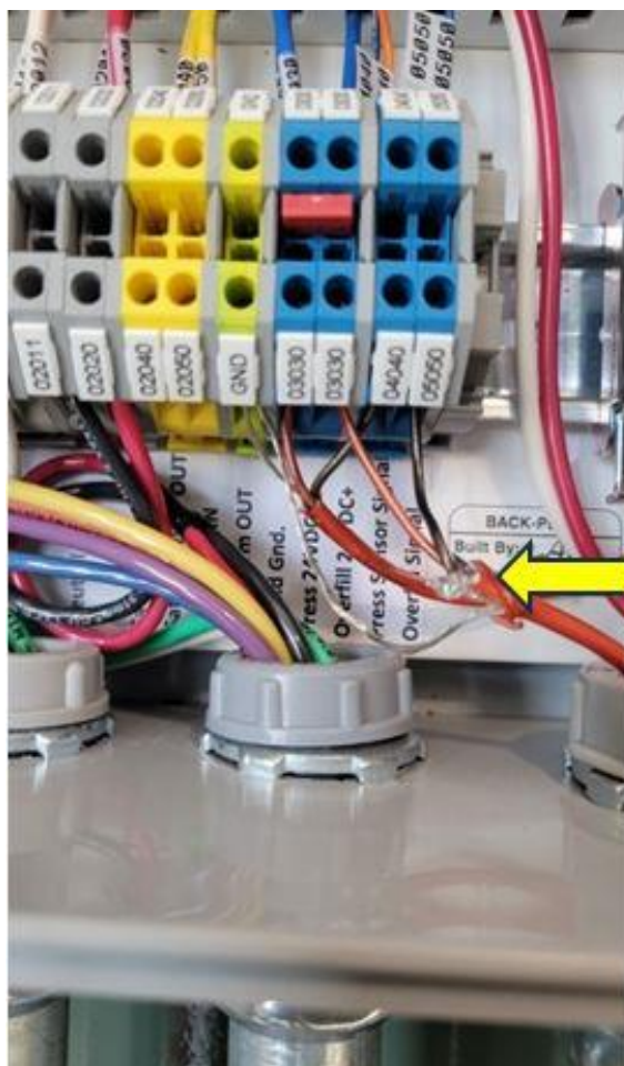
Figura 3-5: Conexiones del panel de control de GREEN MACHINE
