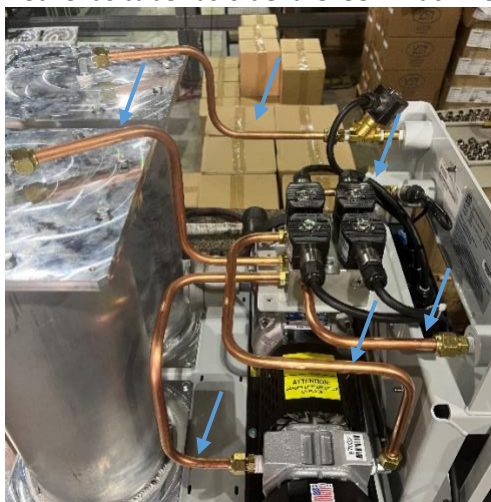
Figura 9-13: Tubería para retirar
