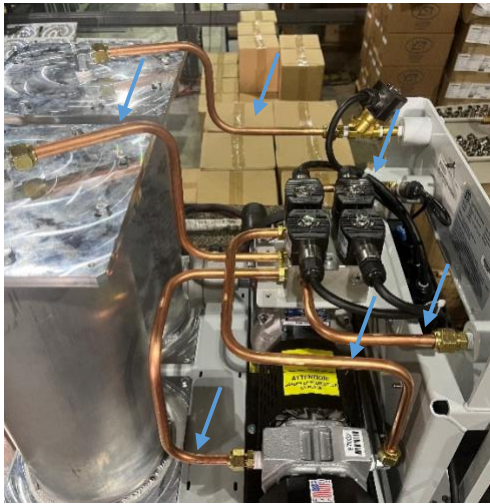
Figura 9-13: Tubería para retirar
