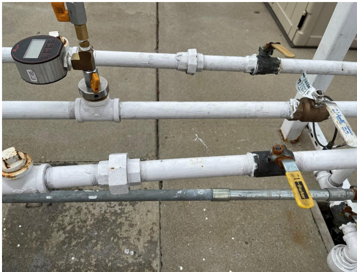
Figura 9-28: Prueba de fugas para GREEN MACHINE
