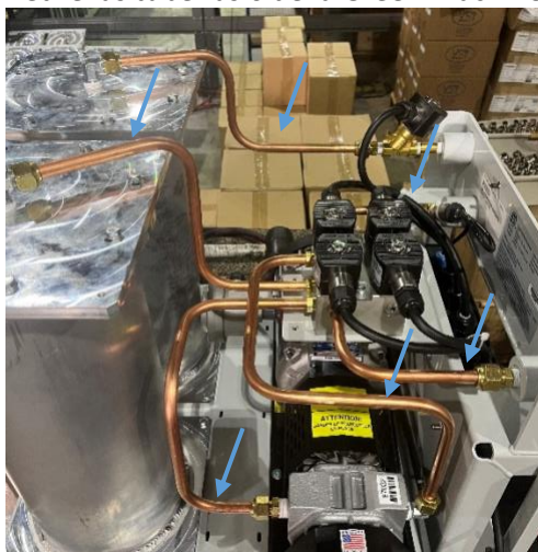
Figura 9-11: Tubería para retirar
