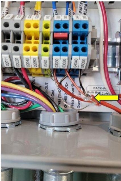
Figura 3-5: Conexiones del panel de control de GREEN MACHINE
