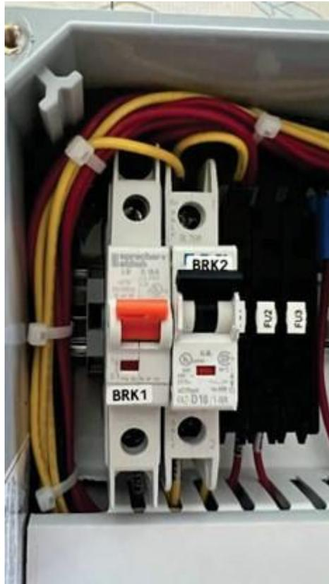
Figura 6-3: Posiciones de los disyuntores del panel de control para realizar mantenimiento en la GREEN MACHINE
