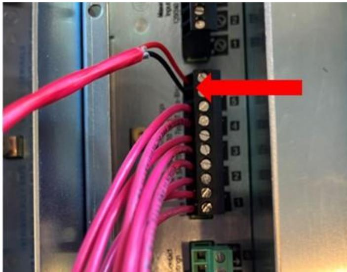
Figura 3-6: Conexión de sobrellenado de GREEN MACHINE
