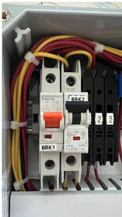
**Figura 8-19: El disyuntor de apagado de derivación del dispensador (BRK2) está ARRIBA (CERRADO)**
