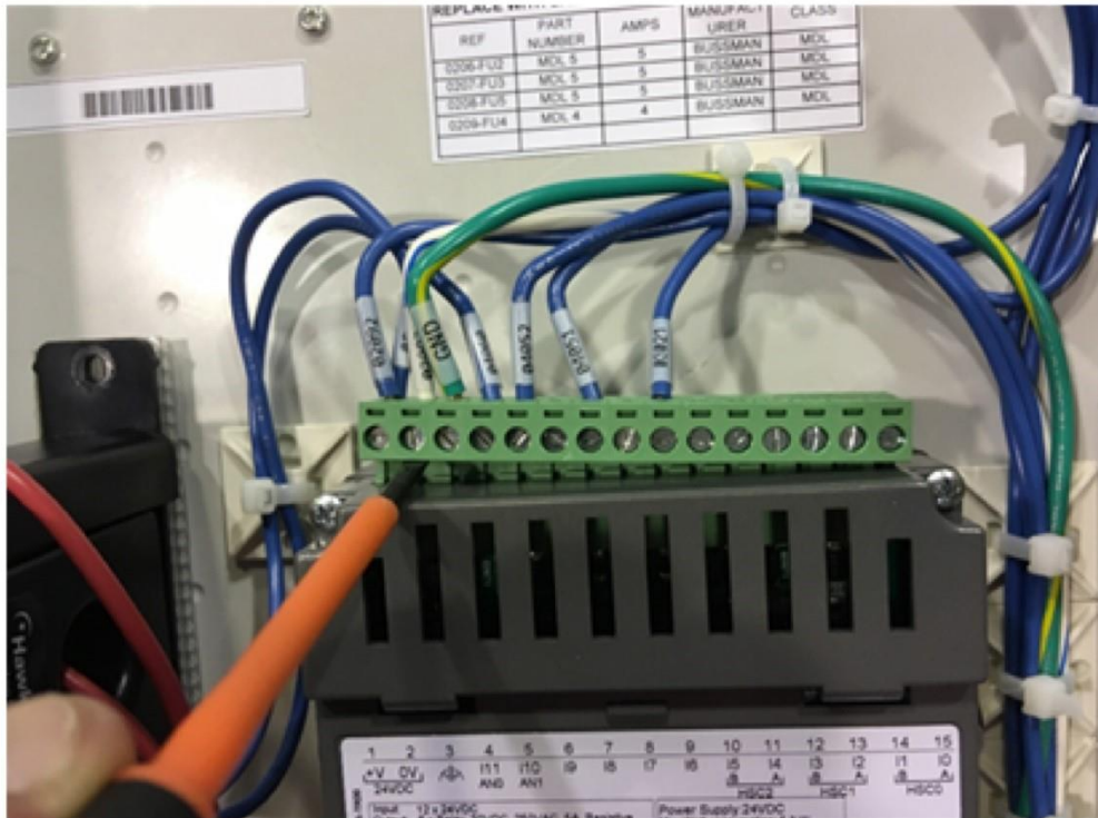
Desmontaje de los conectores del PLC, 2-28-2018
