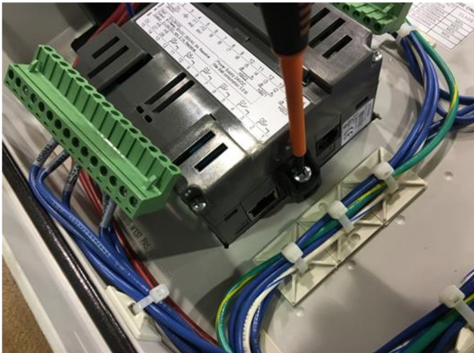
Retirando los sujetadores de retención del PLC, 2-28-2018
