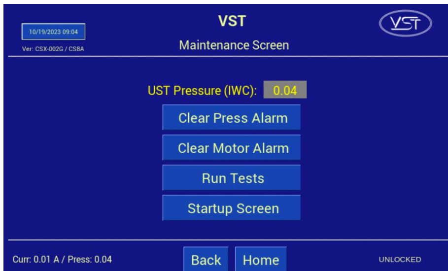
Figura 7-3: Pantalla de mantenimiento
