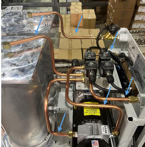
Figura 9-13: Tubería para retirar
