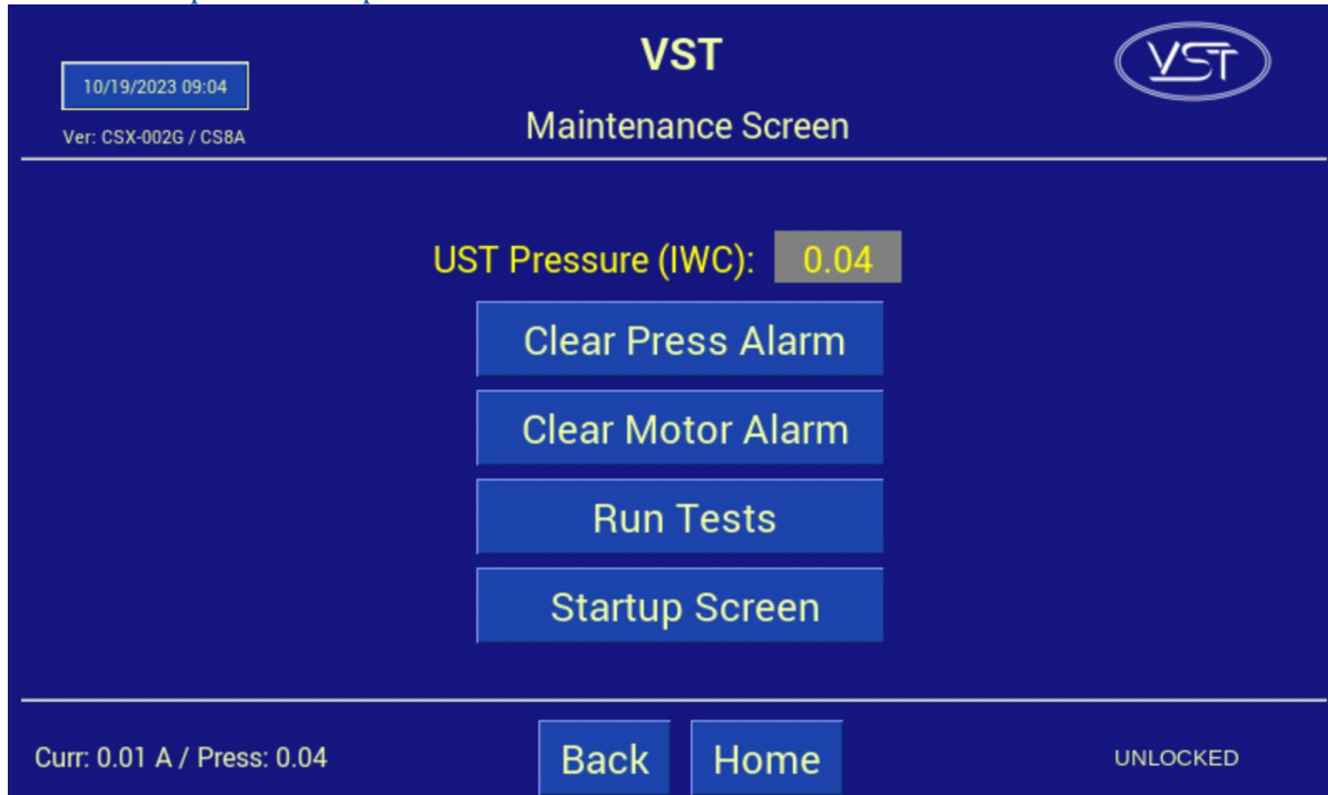
Figura 4-2: Pantalla de mantenimiento
