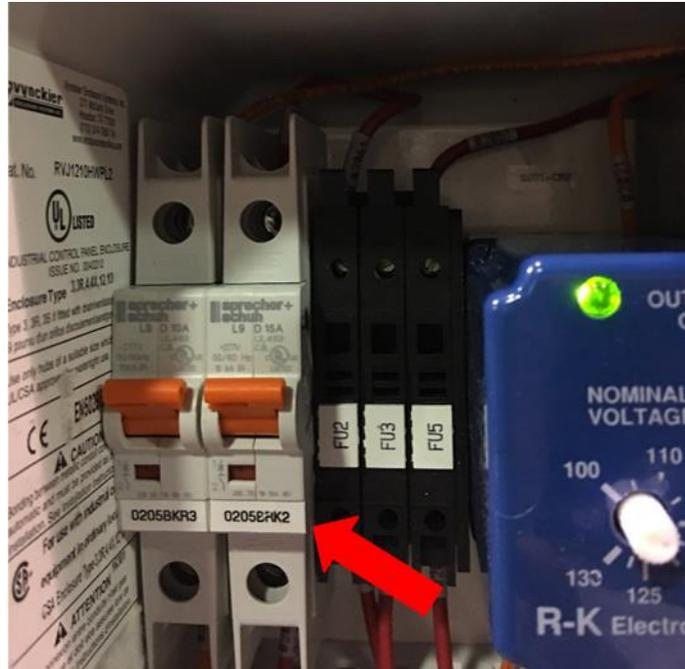
Figura 9-8: Bomba de vacío BRK2
