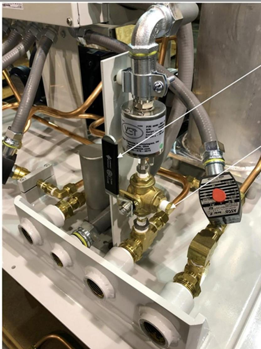
Manija de la válvula de tres vías en posición horizontal (abierto)
