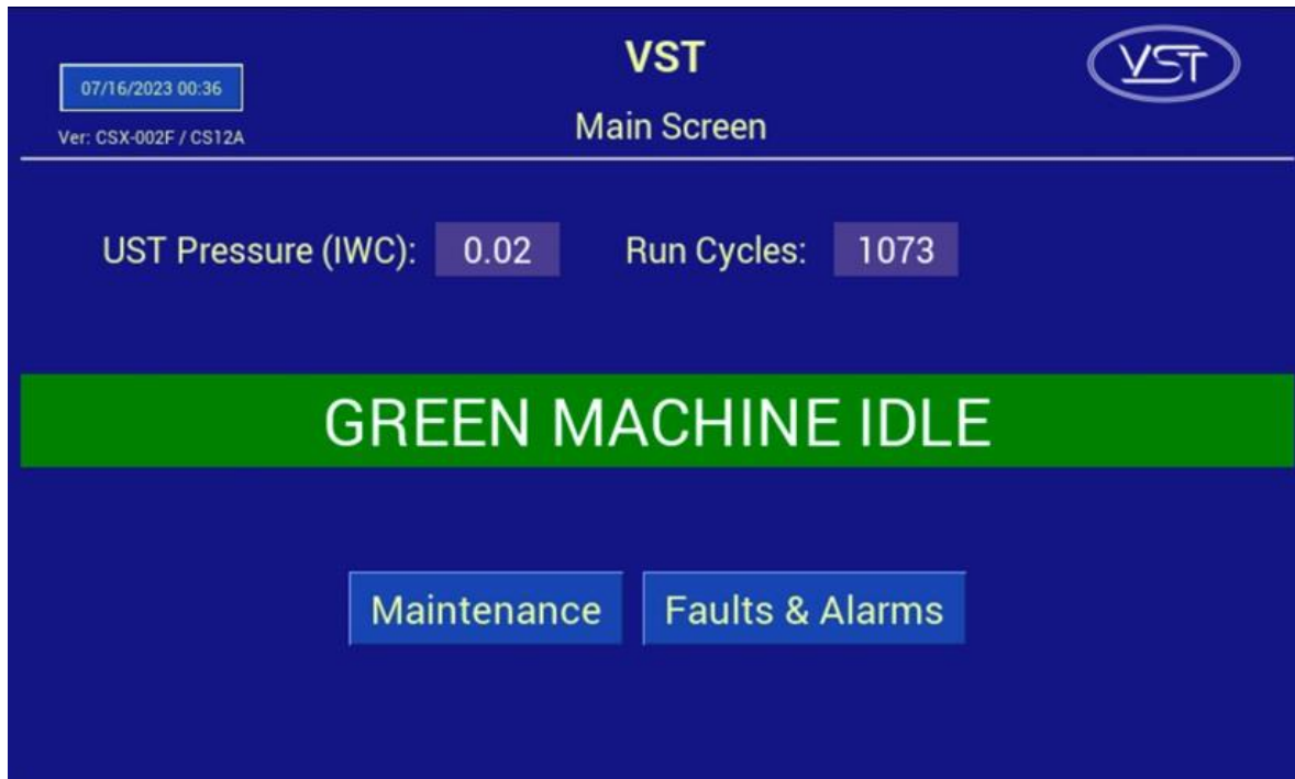
Figura 7-1: Pantalla principal del PLC de VST sin alarmas
