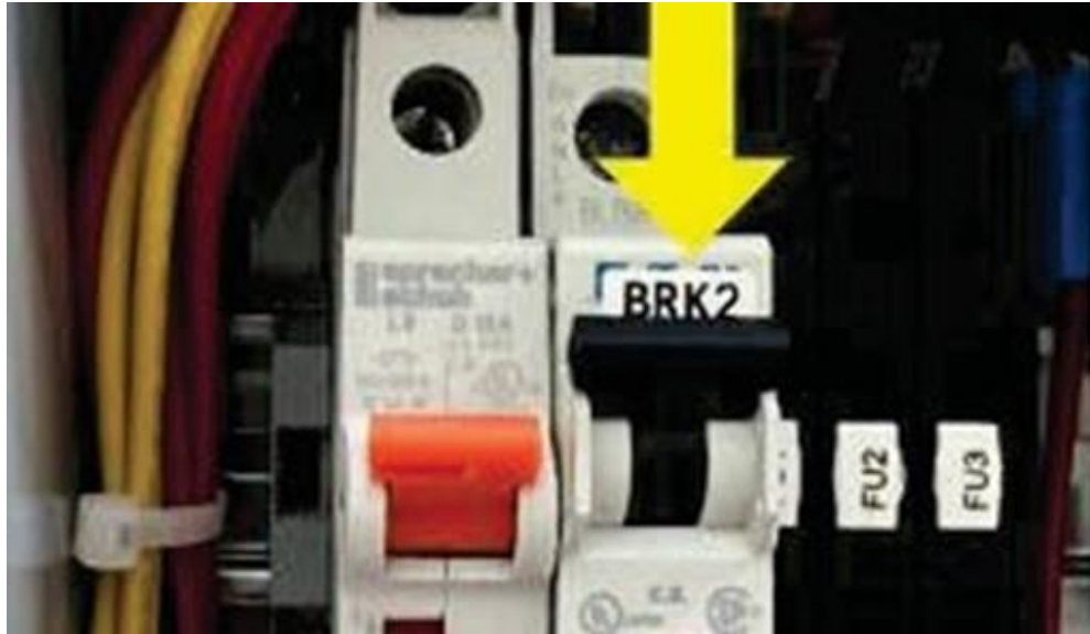
Figura 3-9: Disyuntor de apagado de derivación del dispensador (BRK2) en la posición ARRIBA (CERRADO)
