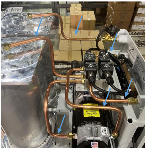
Figura 9-13: Tubería para retirar
