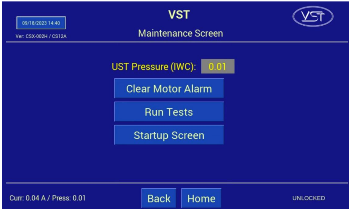
Figura 4-2: Pantalla de mantenimiento
