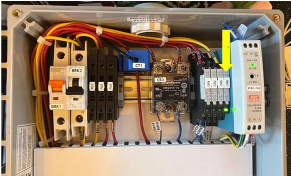
Figura 6-4: El relé CR6 está activo (LED verde brillante)
