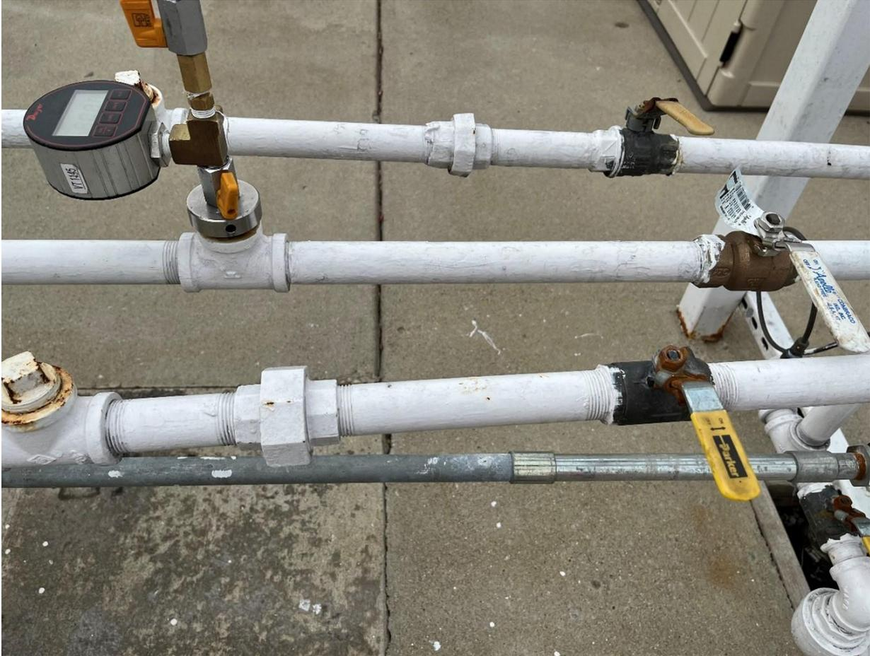
Figura 9-28: Prueba de fugas para GREEN MACHINE
