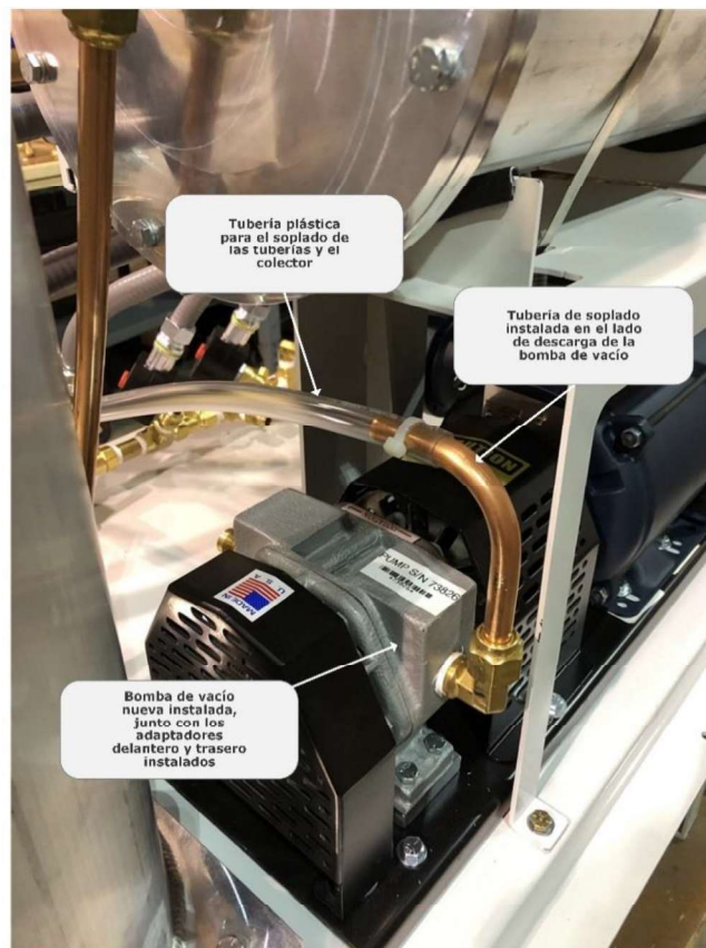
Instalación de los adaptadores y la tubería de soplado de la bomba de vacío en la GM CS9, 27/2/2019
