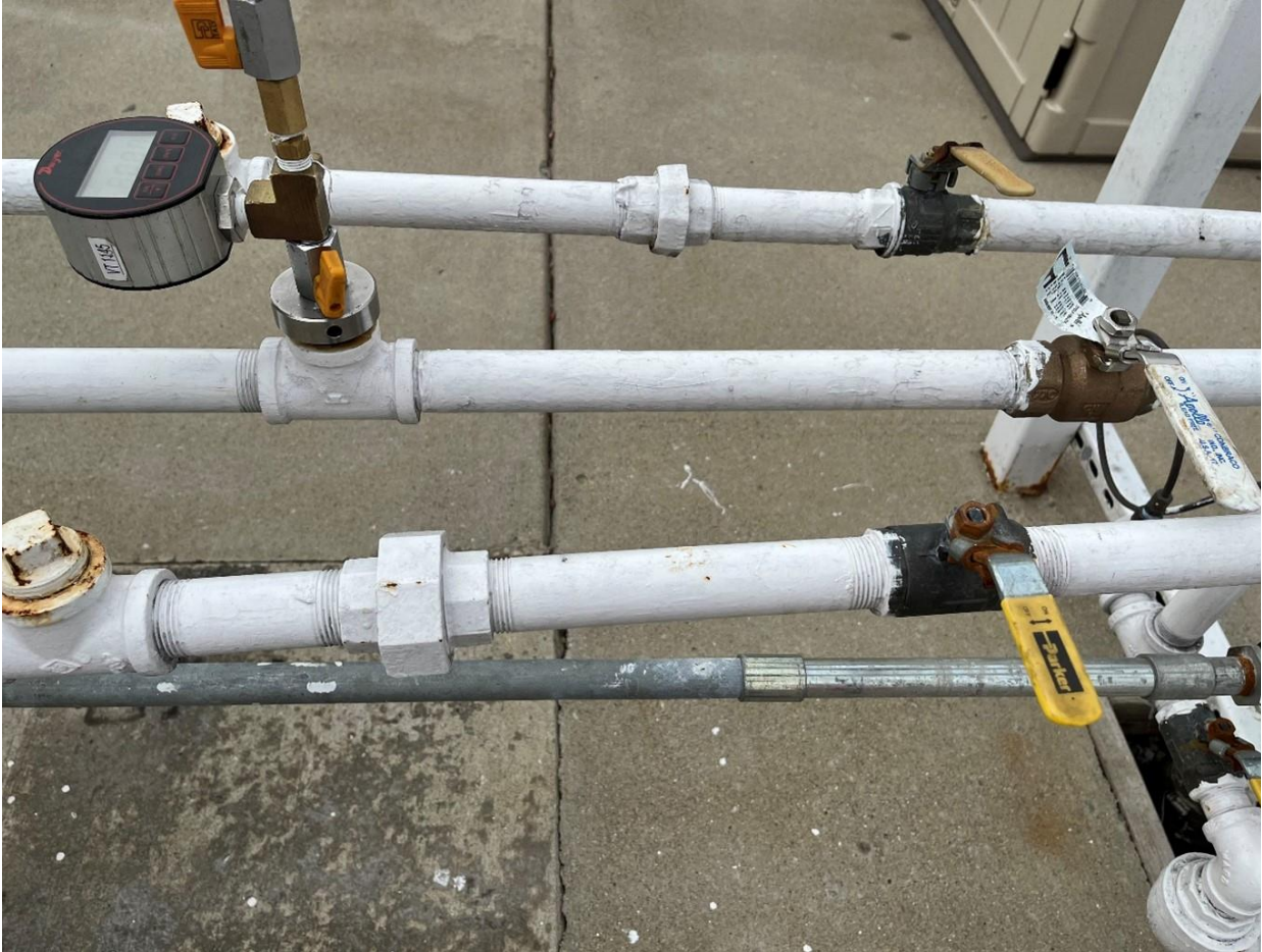
Figura 9-28: Prueba de fugas para GREEN MACHINE
