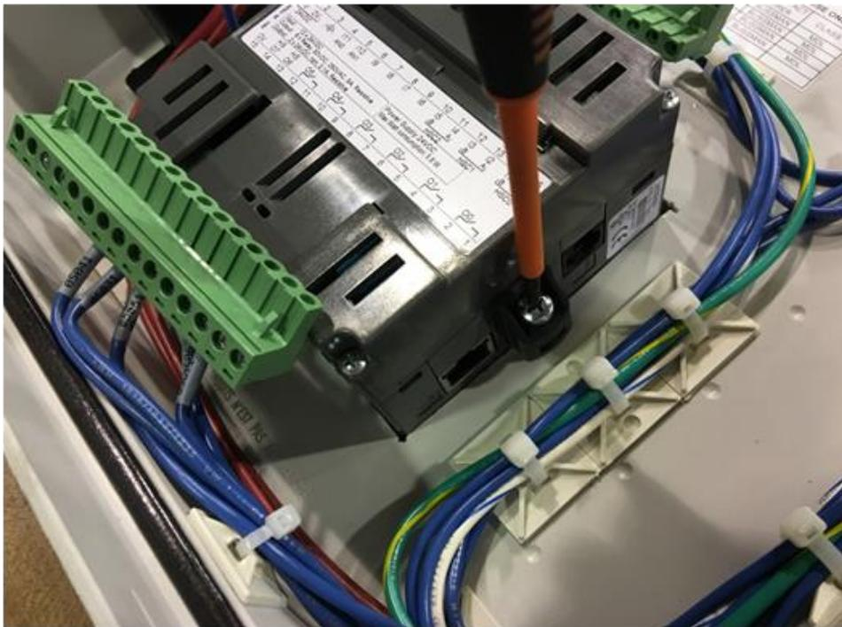
Retirando los sujetadores de retención del PLC, 2-28-2018
