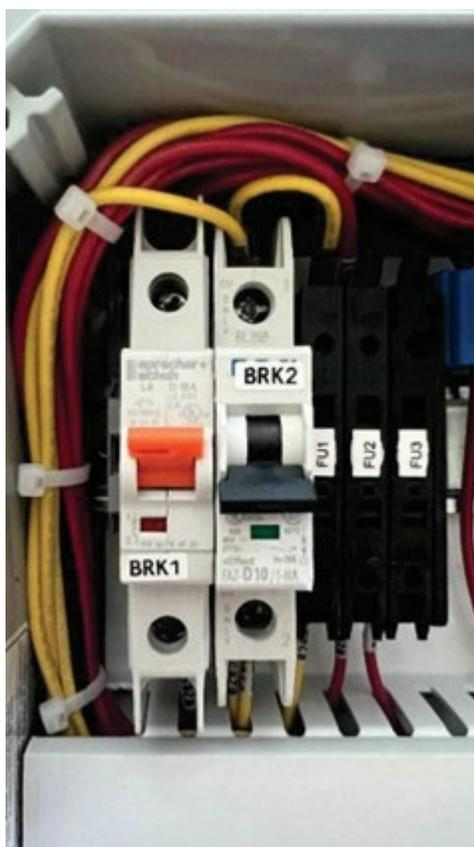
Figure 6-2: Panel de control Posiciones del disyuntor para el funcionamiento adecuado de la estación
