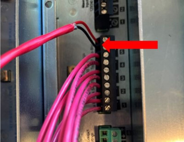
Figure 3-6: Conexión de sobrellenado de GREEN MACHINE
