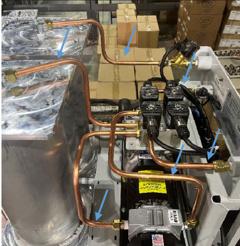
Figure 9-14: Tubería para retirar
