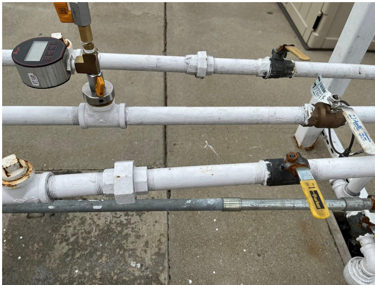
Figure 9-31: Prueba de fugas para GREEN MACHINE
