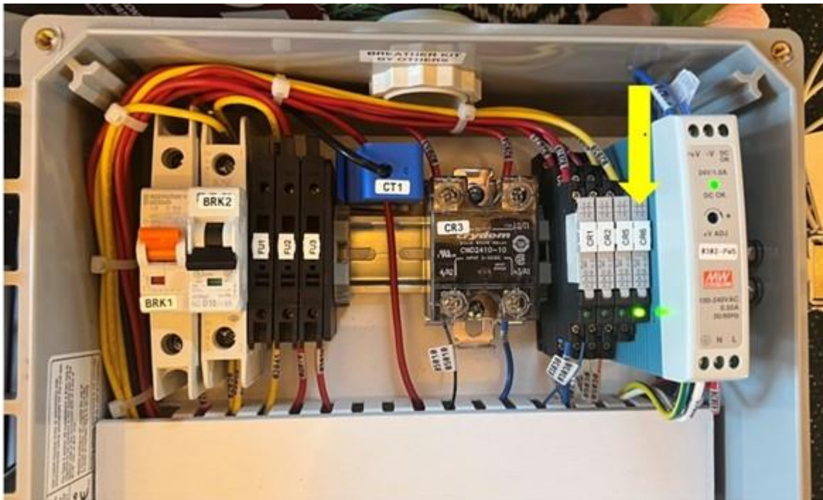
Figure 6-4: El relé CR6 está activo (LED verde brillante)
