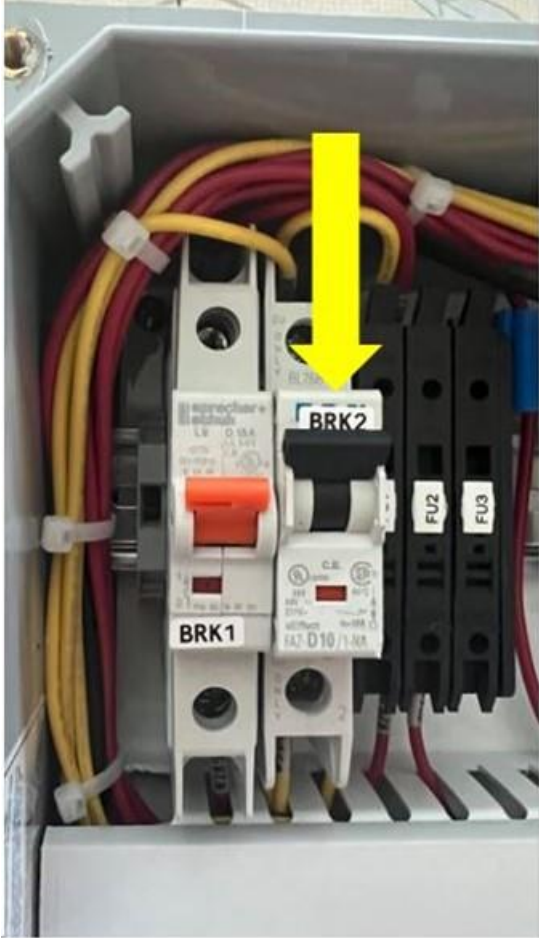
Figure 9-4: Disyuntor de apagado de derivación del dispensador (BRK2) en la posición ARRIBA (CERRADO) durante el mantenimiento.
