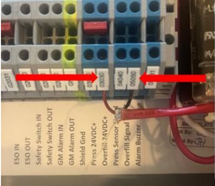
Figure 3-5: Conexiones del panel de control de GREEN MACHINE
