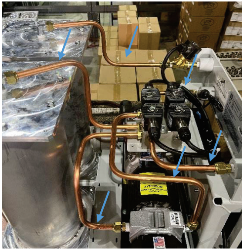
Figure 9-14: Tubería para retirar
