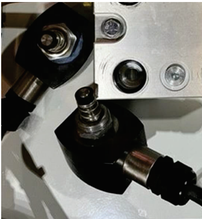
Figura 9-22: Solenoides (con las bases para solenoides instaladas) acomodados y apartados
