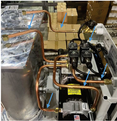
Figura 9-12: Tubería para retirar
