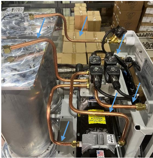
Figura 9-12: Tubería para retirar
