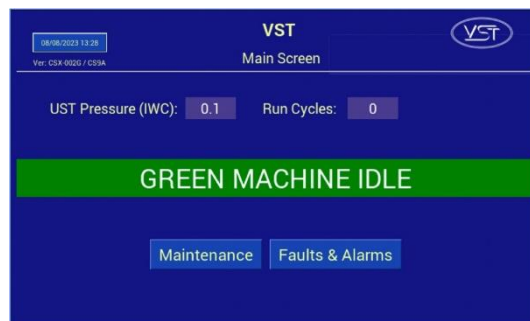
Figura 8-1: Pantalla principal del panel de control del GREEN MACHINE de VST
