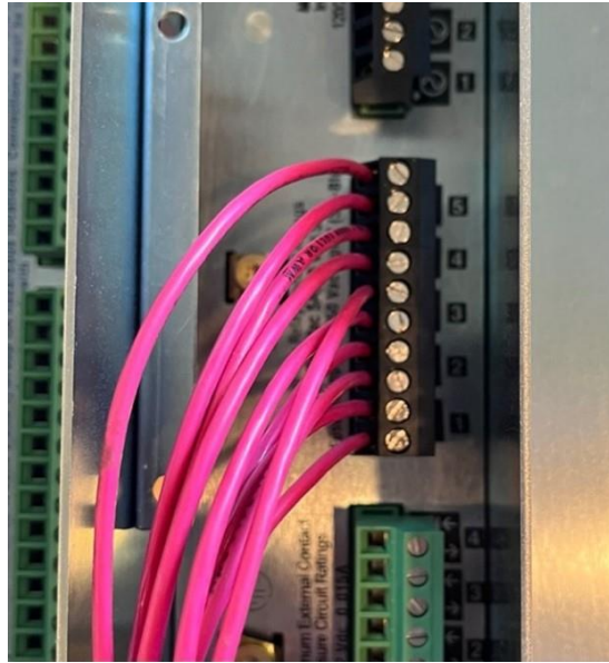
Figure 3-4: No hay relés disponibles en el módulo de E/S
