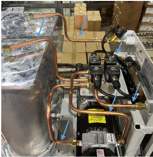
Figure 9-14: Tubería para retirar
