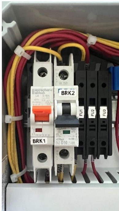
Figure 8-21: Disyuntor de apagado de derivación del dispensador (BRK2) en posición bajada (ABIERTO)
