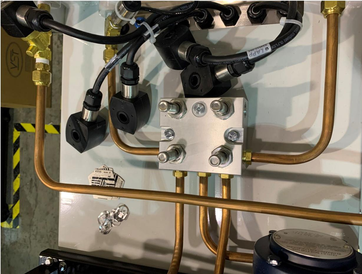
**Figure 9-20: Colector con los solenoides retirados, mostrando las bases de solenoides**
