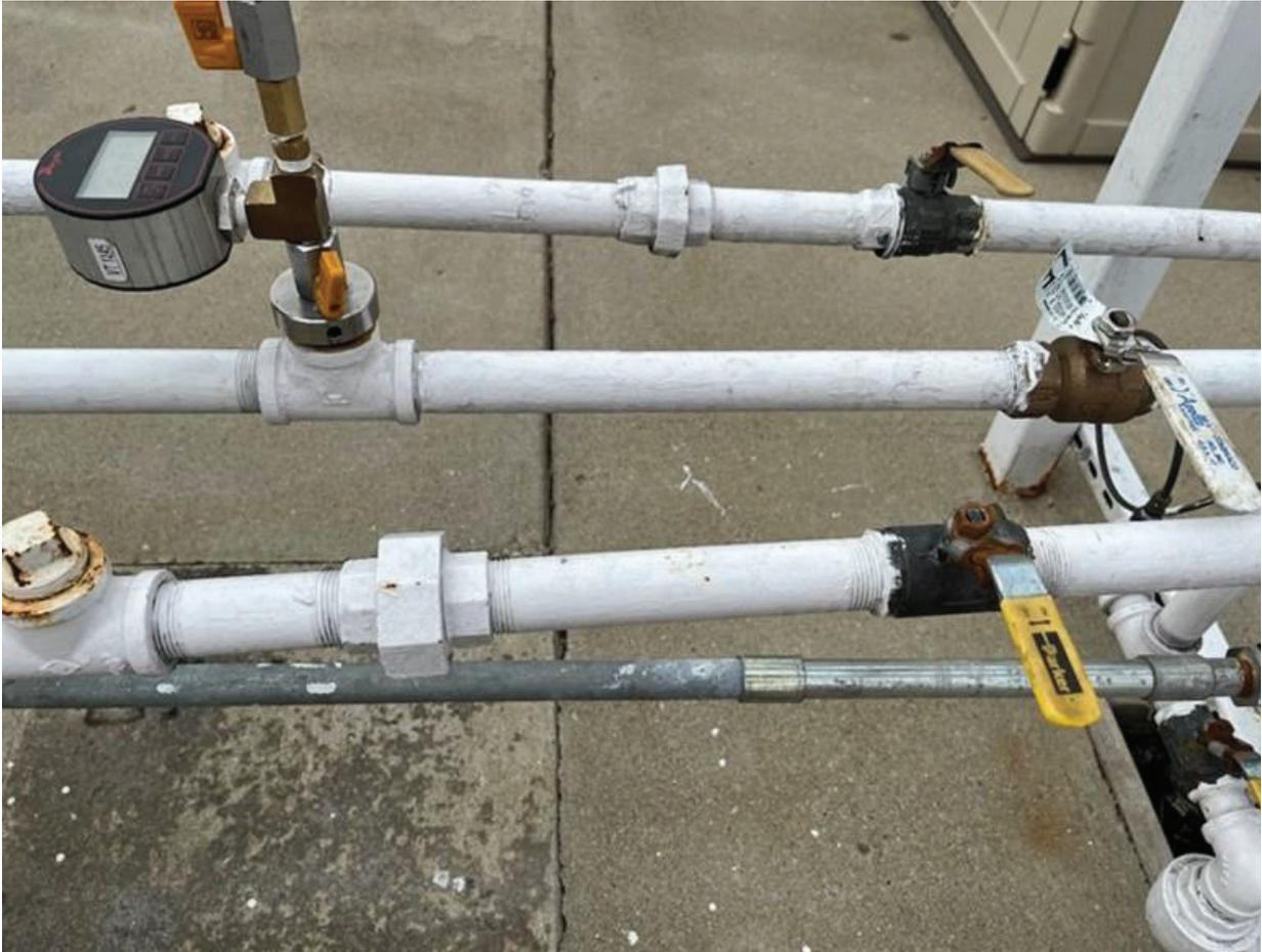
Figure 9-31: GREEN MACHINE con las tuberías de ingreso y retorno de vapor y salida de aire
