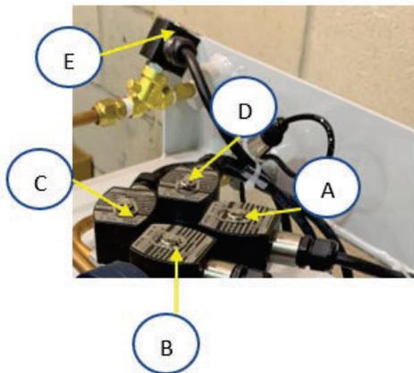
Figure 8-9: Válvulas de control
