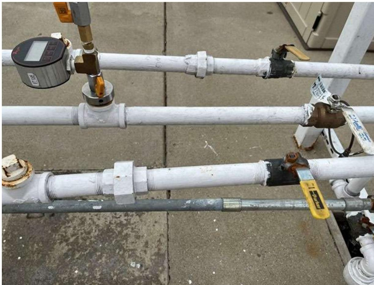
Figure 9-31: GREEN MACHINE con las tuberías de ingreso y retorno de vapor y salida de aire
