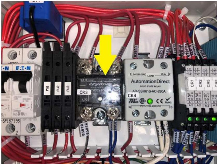
Figure 9-4: Relé de estado sólido de la bomba de vacío
