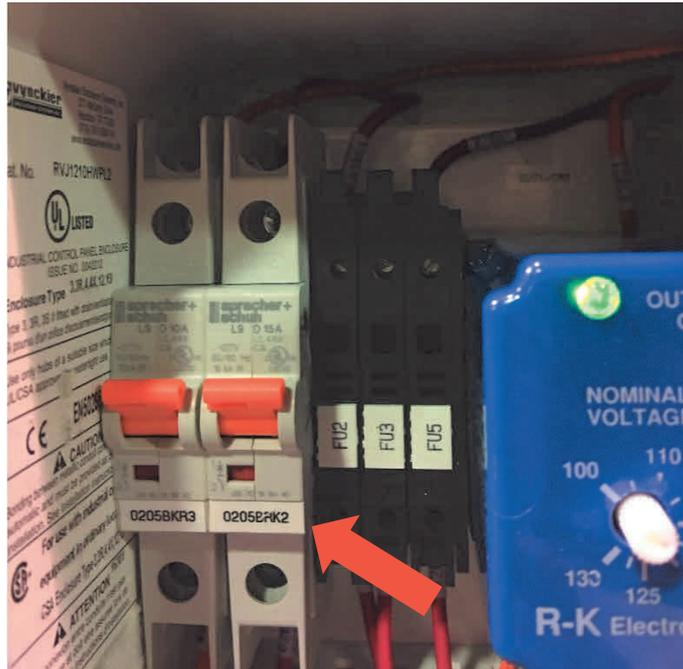
Figura: 9.8 Bomba de vacío BRK2
