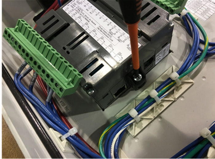
Extracción de los sujetadores del PLC, 28-2-2018
