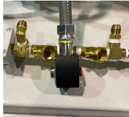
Figura: 9.30 Solenoides con base del solenoide y tapón rojo instalados
