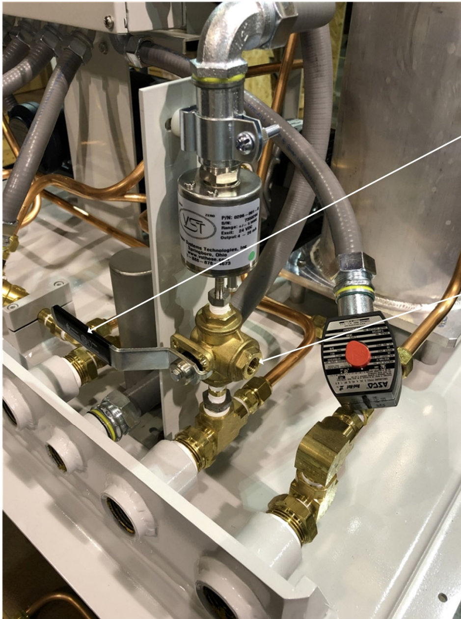
Figura: 7.9 Sensor de presión y válvula de 3 vías, posición de prueba
