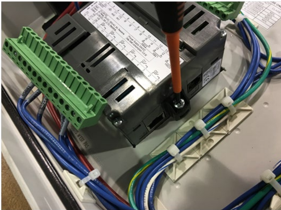
Retirando los sujetadores de retención del PLC, 2-28-2018
