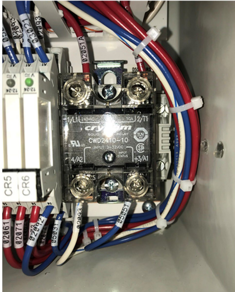
Figura 9-9: Relé de estado sólido de la bomba de vacío
